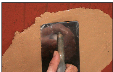
Etape 1 - application directe sur brique plâtrière légèrement humidifiée (pas de sous couche de fond ou d'accroche)
