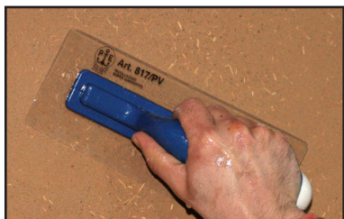
Etape 3 - à mi-séchage, resserer l'enduit à l'aide d'une spatule plastique souple.
